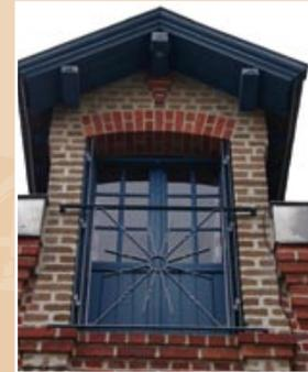
**Porte d'entrée vitrée et grille de ferronnerie.** Elle est surmontée d'une imposte vitrée.
