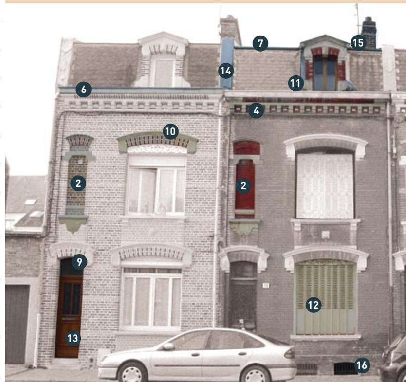
Les ouvertures (fenêtre, porte, lucarne) sont rares et toujours plus hautes que larges. Pour améliorer l'intensité de l'éclairage naturel dans la maison, les menuiseries extérieures sont peintes d'une couleur claire voire blanche. Quelquefois, l'embrasure et l'appui de fenêtre sont recouverts d'un badigeon également de couleur claire.
