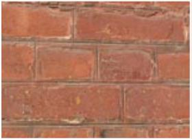
**Badigeon de couleur rouge.** Il protège les maçonneries de brique de mauvaise qualité. Le badigeon est un mélange de chaux naturelle et de pigments.
