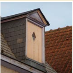
Lucarne à «bâtière». Sa toiture a 2 pans, fermeture par volet plein.
