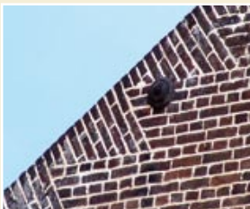
Appareillage «à couteaux». Terminaison haute du pignon qui permet de constituer un angle régulier, en brique ou en brique et moellons de craie.
