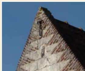
Appareillage «à couteaux». Terminaison haute du pignon qui permet de constituer un angle régulier, en brique ou en brique et moellons de craie.
