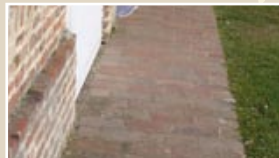
Trottoir en brique, en pied de façade.
