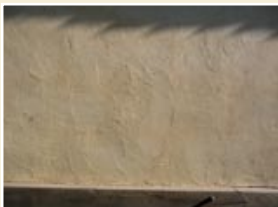
Badigeon. Recouvre les parois de torchis. Le badigeon est un mélange de chaux naturelle et de pigments.
