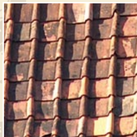
Tuile mécanique dite «panne» de couleur orange.
