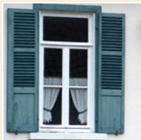
Fenêtre à deux ouvertures ou «vantaux». Ici, elle est surmontée d'une imposte vitrée.
