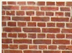
Brique du Nord. Sa dimension est d'environ L= 22 x 11 x 6 cm, sa forme et sa couleur varient selon les argiles qui la composent et la durée de cuisson artisanale.
